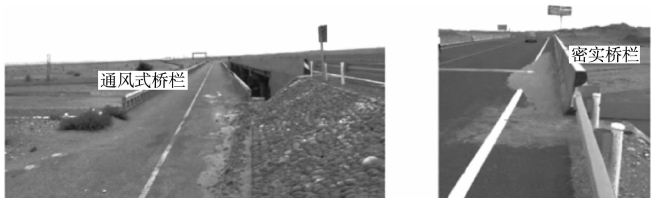
新旧桥面积沙状况照片 (a. 旧桥面无积沙; b. 新桥面有积沙)
